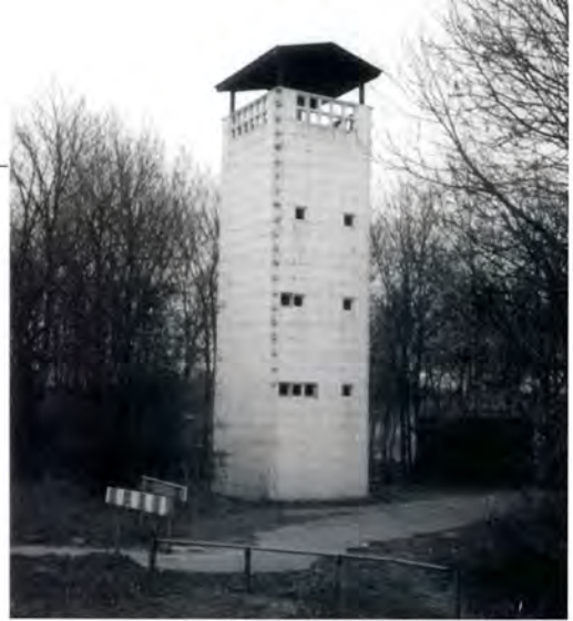
Raabouwtoeren Ens (Flevoland). Afwijkend van standaardtype door een andere breedte en hoogte, een dichte constructie en het ontbreken van een uitkragende bovenkant. (foto: S. van Lochem)
