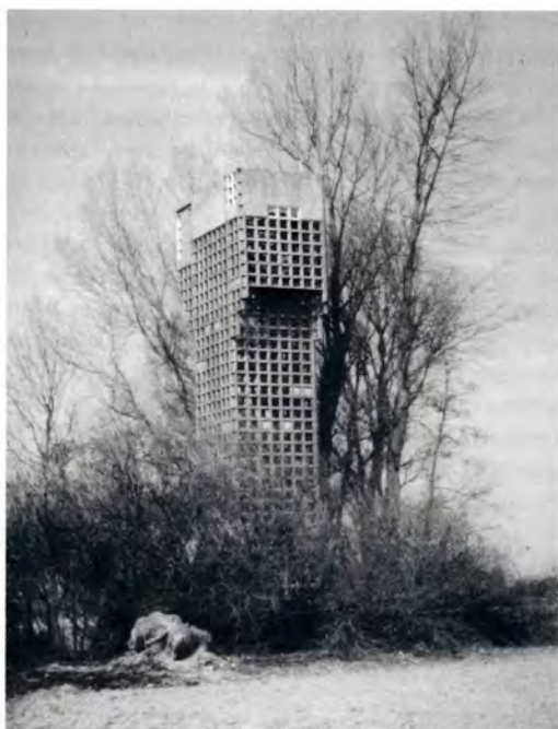
Luchtwachtoren Den Horn (Groningen). Hoogte 13,92 m. Ter camouflaflage in een verder open landschap zijn om de toren hoog opgroeiende bomen geplant. (foto: S. van Lochem)
