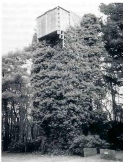
Luchtwachtoren Bladel (Noord-Brabant). Hoogte 11,64 m. De klimop tegen de toren diende als camouflaflage. (foto: S. van Lochem)
